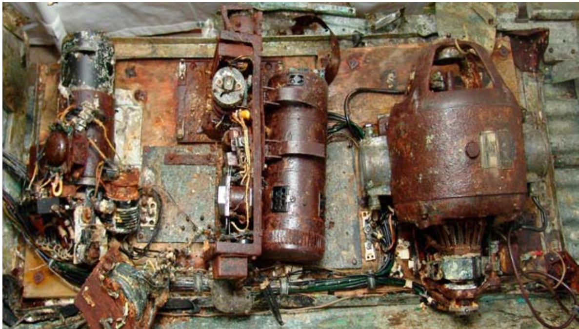
T250, omformare i elcentral ovanifrån. Två 110 V omformare till vänster och en 220 V till höger. Foto 04149 CM.
