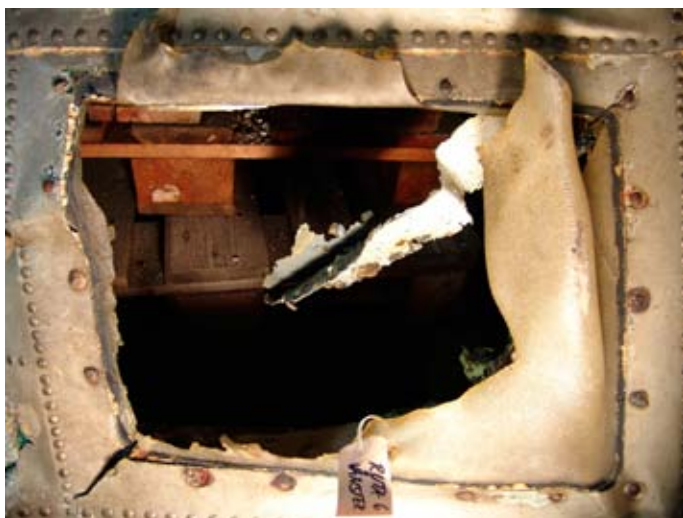
Fönster nr 6 på vänster sida. Observera att plexiglasen är kraftigt böjt och knottigt.
