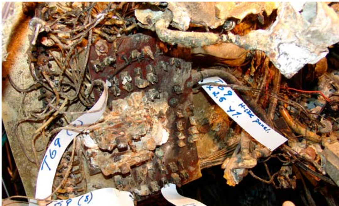
T069, säkringspanel och kopplingscentral.
